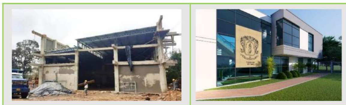
Figura B. Estado actual y estado ideal de la obra a noviembre 30, 2020.
