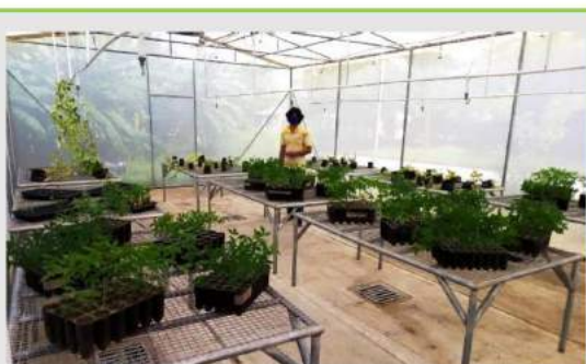
instalaciones de casa de malla climatizada en Sena Cartagena.
