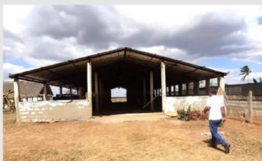
Instalaciones destinadas al montaje de los equipos.
